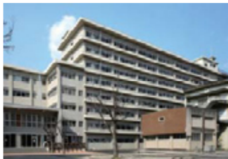
医学系総合実験研究棟改修 平成21年3月完成
