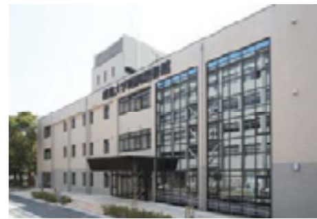
附属図書館(常三島本館)改修 平成21年3月完成
