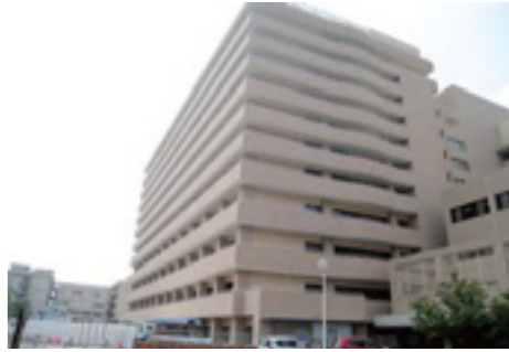
医学部・歯学部附属病院 西病棟 平成21年8月完成
